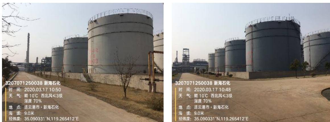
图 4.3-3 部分罐区现场踏勘照片
