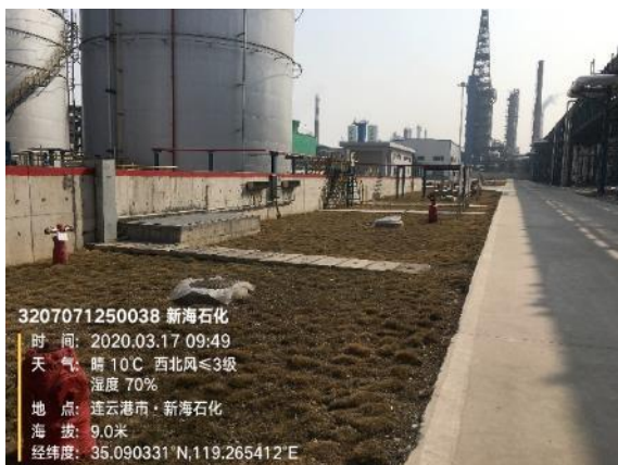
污水或污油地下输送管线
