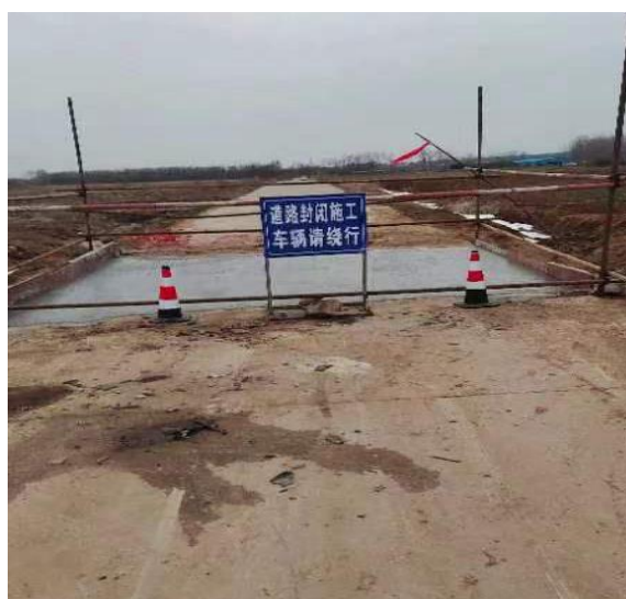
管道工程区—路面恢复
