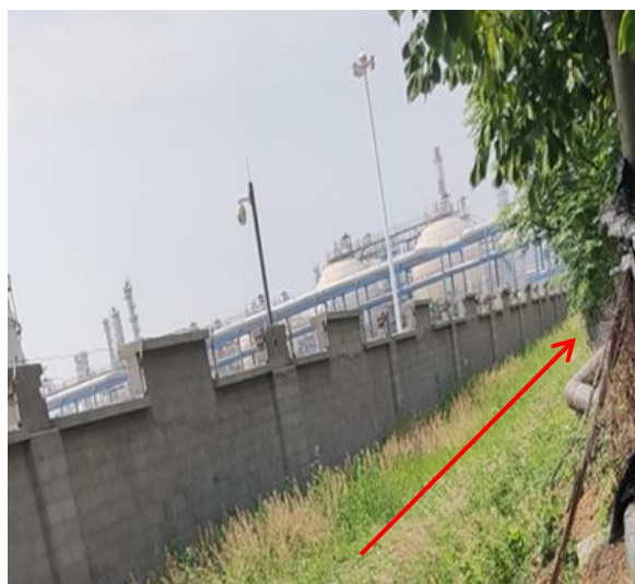
管道工程区绿化
