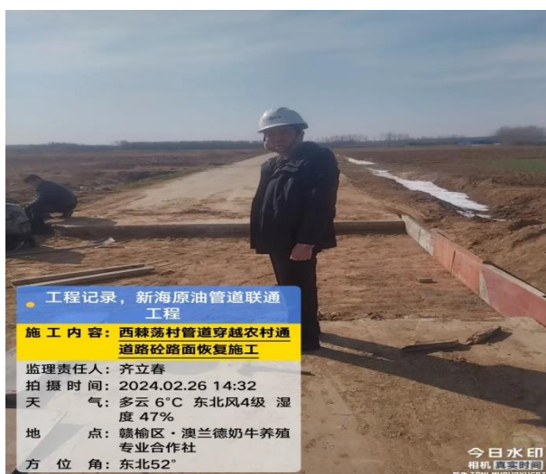
管道工程区—路面恢复
