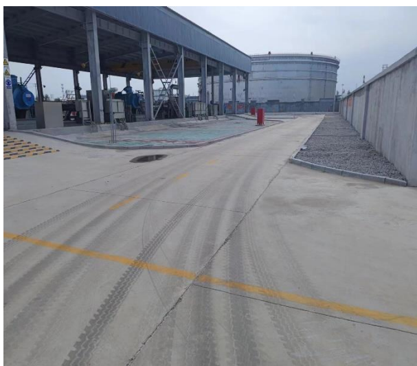
末站工程区道路及硬化地面
