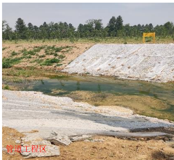
混凝土硬质护坡
