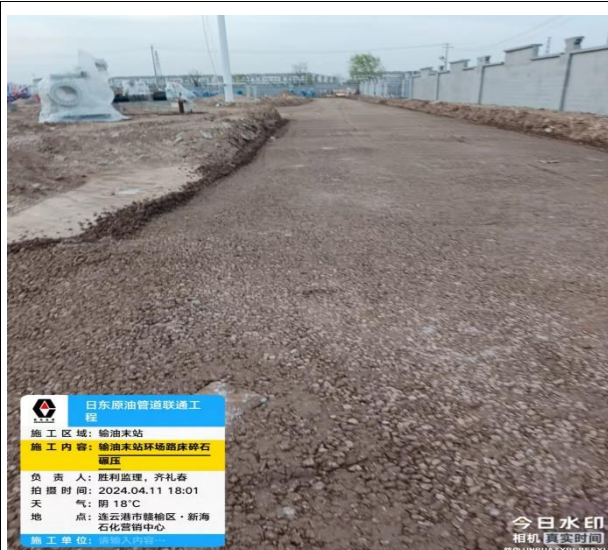
末站工程区道路铺设
