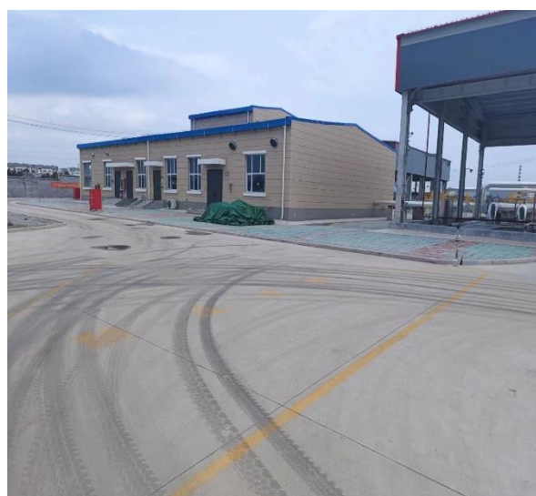
末站工程区道路及硬化地面
