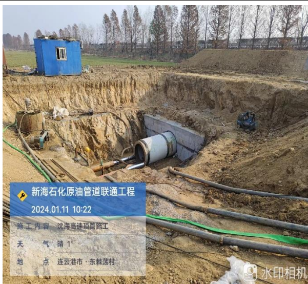
顶管施工
