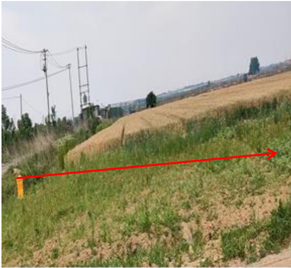
管道工程区复耕
