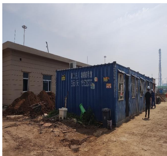
末站工程区道路铺设施工生产生活区
