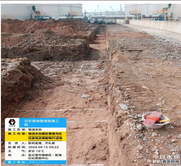
末站工程区管沟定位
