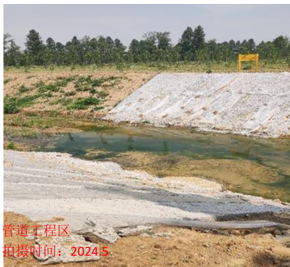
混凝土硬质护坡
