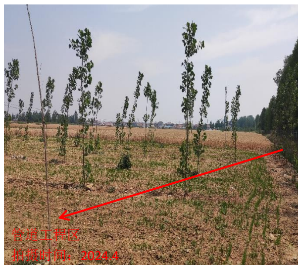
管道工程区复耕
