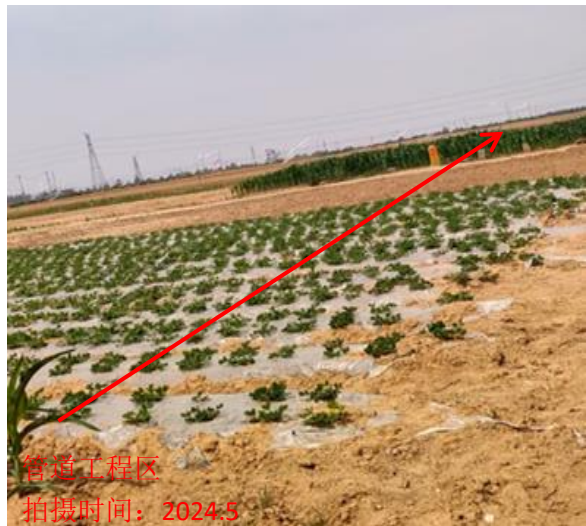
管道工程区复耕
