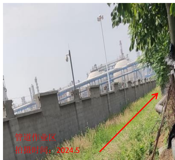
管道工程区绿化
