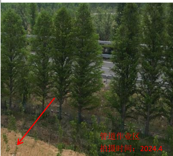
顶管穿越沈海高速
