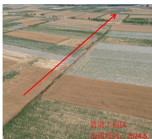
管道工程区复耕
