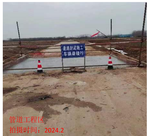
管道工程区路面恢复
