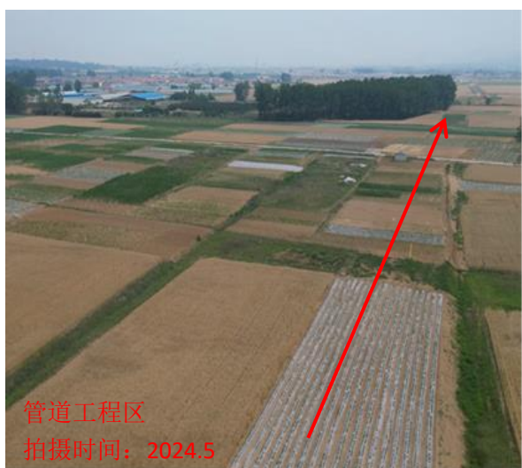
管道工程区复耕
